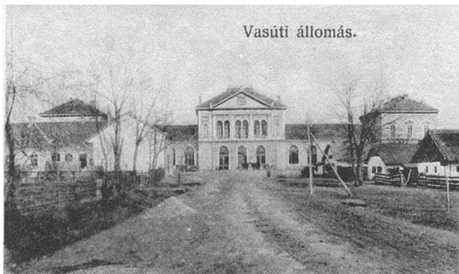
41. kép: Korabeli kép a vasútállomás és környezetéről. Forrás: Zombor L. Képeslapgyűjteménye
