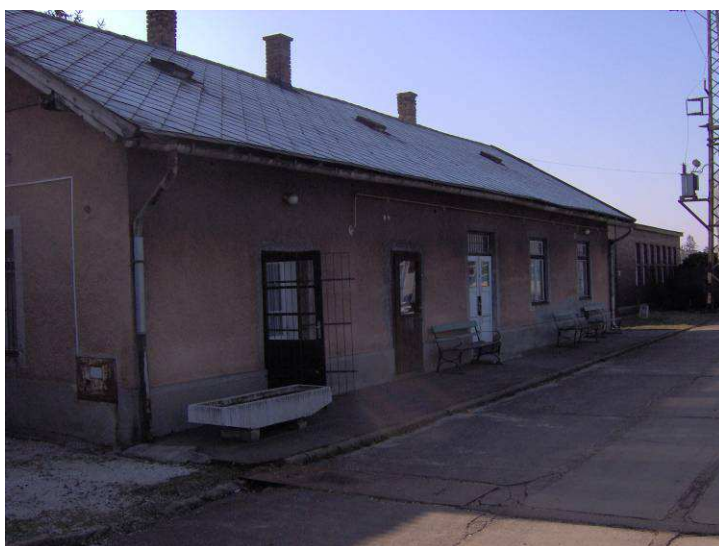
42. kép: Az 1870-ben átadott állomásépület. Forrás: Saját felv.
