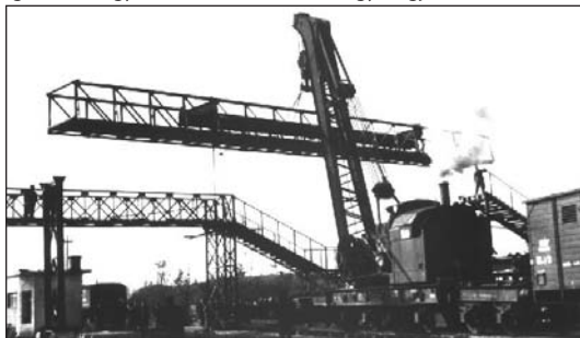
1961: hídbontás és hídepítés a vasútvonal villamosításakor
