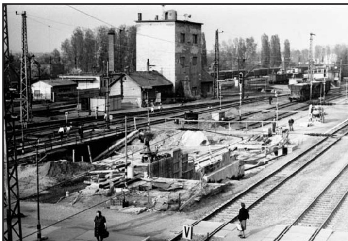
A vasúti aluljáró építése - az aluljáró 1987-ben elkészült
